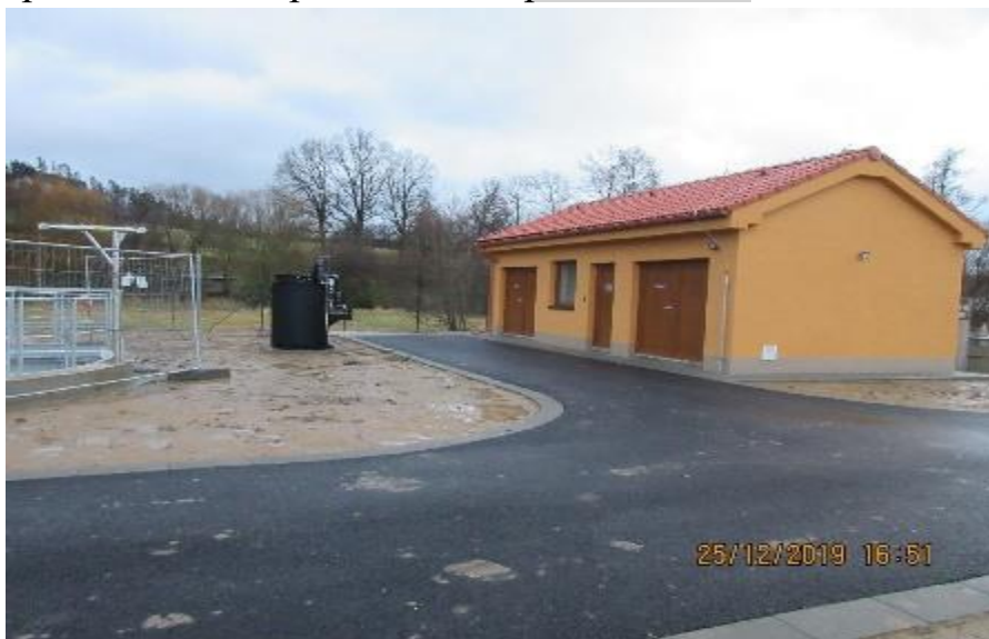
Nová čistírna odpadních vod
